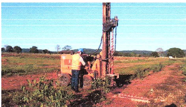
Foto 40 – Execução da sondagem denominada de PML 04
