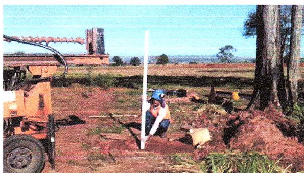
Foto 23 – Detalhe do revestimento do Poço de monitoramento PML 02
