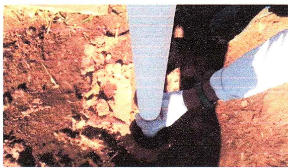
Foto 24 – Detalhe do revestimento do Poço de monitoramento PML 02
