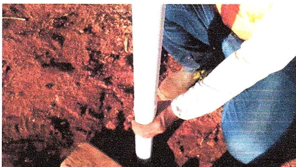
Foto 14 – Detalhe do revestimento do Poço de monitoramento PML 01
