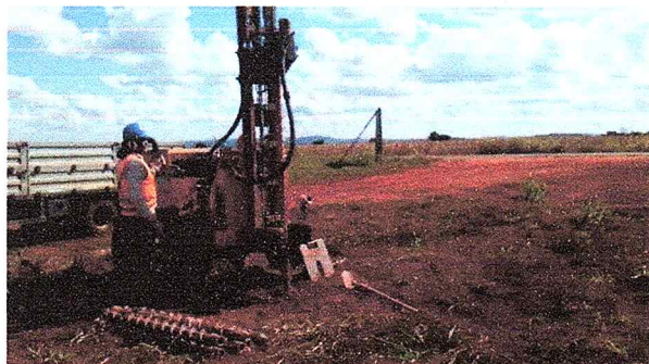
Foto 09 – Execução da sondagem denominada de PML 01
