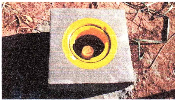
Foto 26 – Poço de monitoramento PML 02 finalizado
