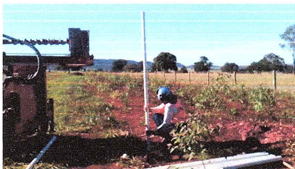
Foto 43 – Detalhe do revestimento do Poço de monitoramento PML 04
