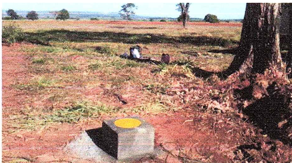
Foto 25 – Poço de monitoramento PML 02 finalizado
