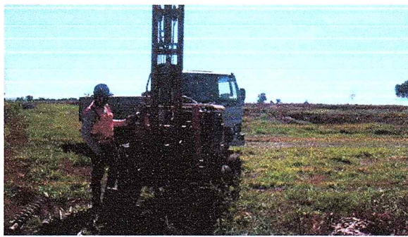
Foto 30 - Execução da sondagem denominada de PML 03
