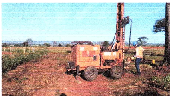
Foto 19- Execução da sondagem denominada de PML 02
