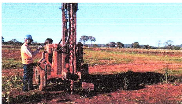
Foto 39 – Execução da sondagem denominada de PML 04
