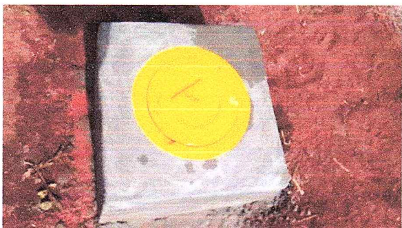
Foto 15 – Poço de monitoramento PML 01 finalizado
