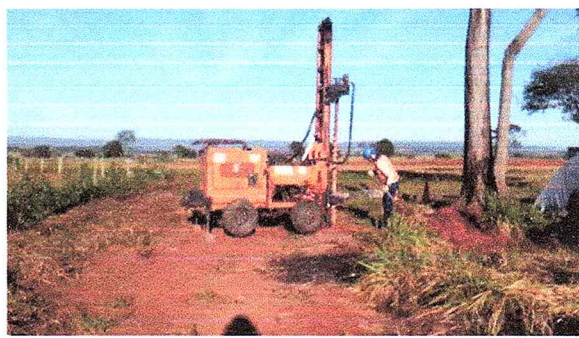
Foto 20: Execução da sondagem denominada de PML 02
