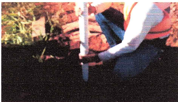
Foto 44 – Detalhe do revestimento do Poço de monitoramento PML 04
