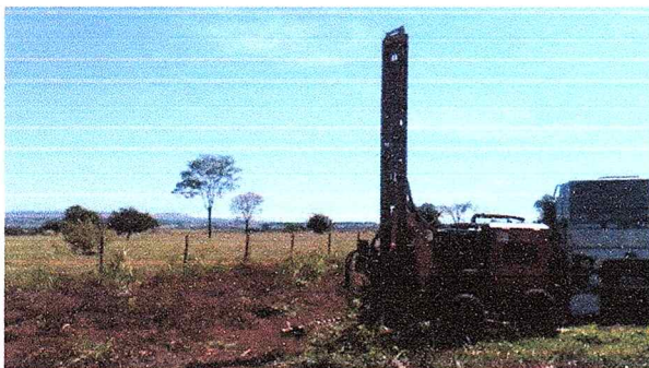
Foto 29 - Execução da sondagem denominada de PML 03
