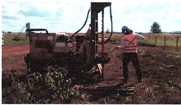
Foto 10 – Execução da sondagem denominada de PML 01
