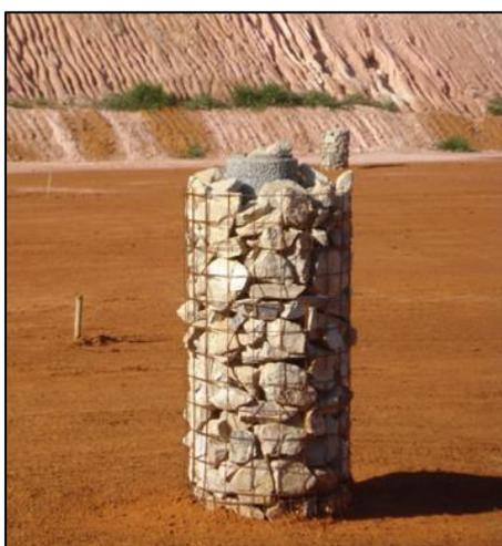
Figura 16: Exemplo de dreno de gases implantado.
