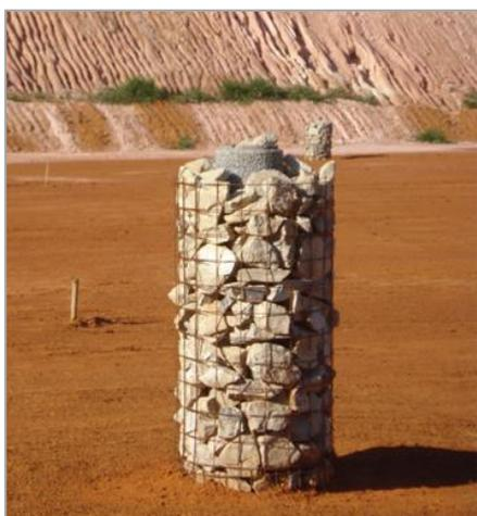
**Figura 15: Exemplo de dreno de gases implantado.**
