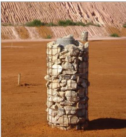
Figura 36: Exemplo de dreno de gases implantado
