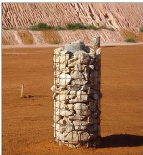
**Figura 10: Exemplo de dreno de gases implantado**
